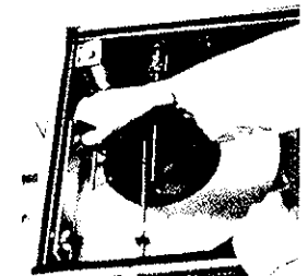
6. Tuloilmapuhaltimen siipimutterit irroitetaan
