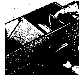
4. Tuloilmasuodatin poistetaan
