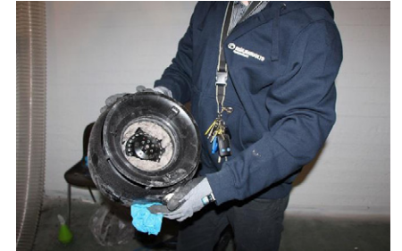
Jos ilmanvaihtoa ei huolleta oikein, osa irronneesta liasta kertyy esimerkiksi huippumurin hattuun ja pahimmassa tapauksessa tukkii järjestelmän.
