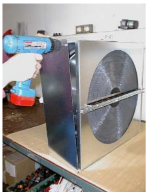
Kuva 1 Kannen avaaminen, 6 kpl ruuvia
