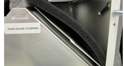
Lto-kenno kesä asennossa, pelti käännetty siirtimen eteen, ulkoilma ohittaa kennon takaa -asetta jälkilämmityksen termostaatti 0-asentoon
